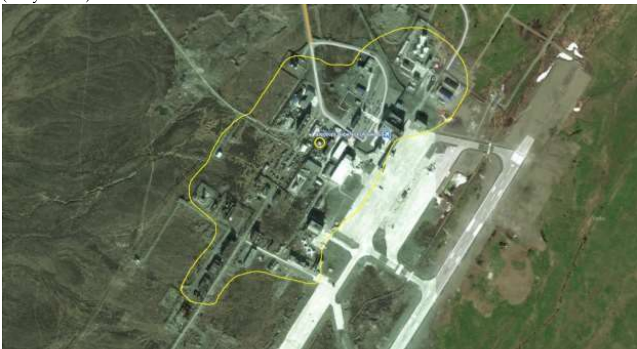
Рисунок 12 - Зона действия котельной аэропорта «Алыкель»
